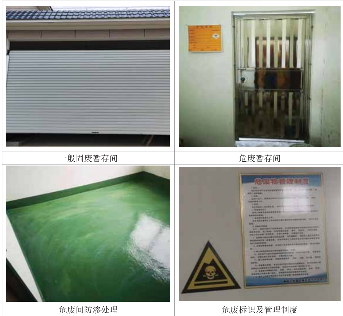
图 4.1-4 固废治理设施图
