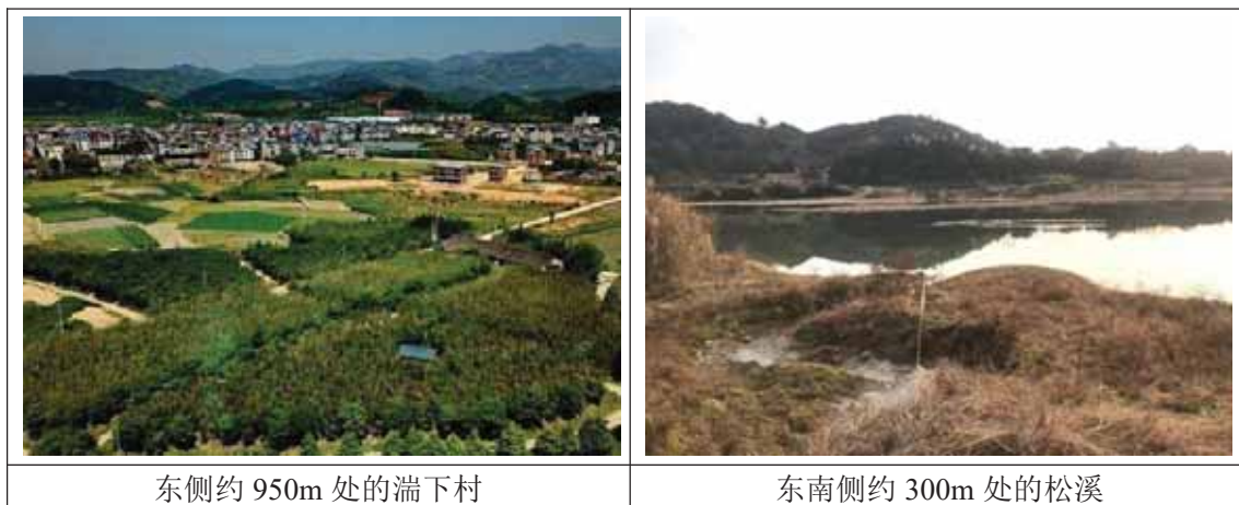
图 3.1-4 项目周边环境现状照片
