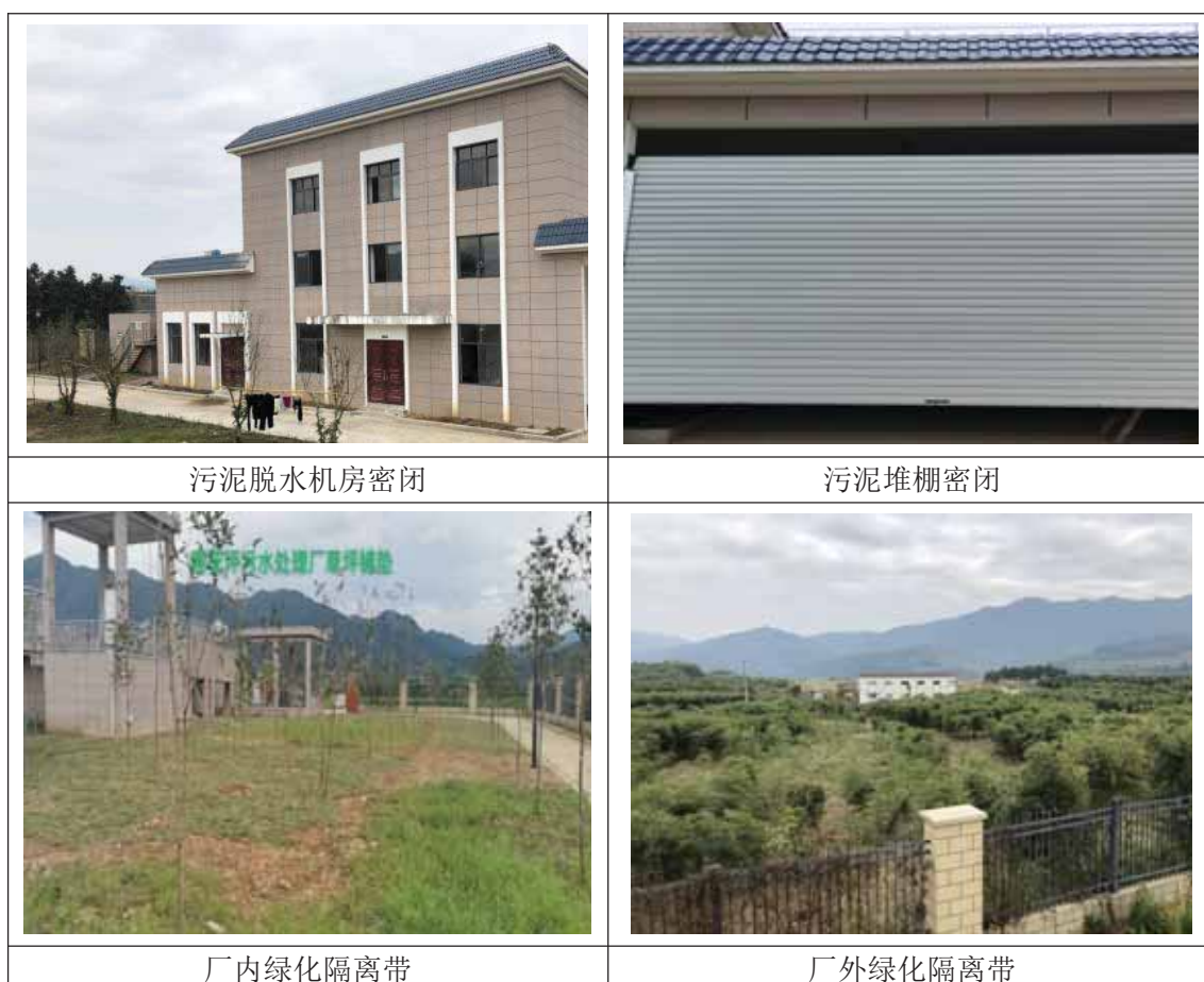
图 4.1-2 废气治理设施图
